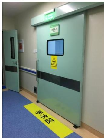
图6-1 机房操作位、观察窗、操作规程上墙 图6-2 工作指示灯、电离辐射标志
